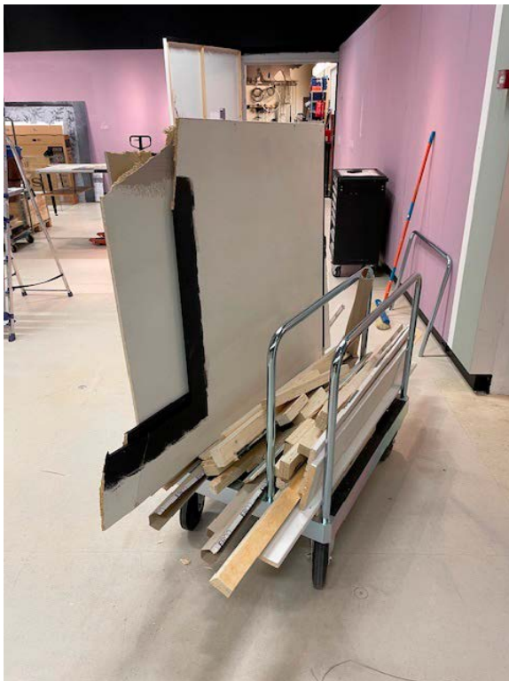
Satakunnan Museon Englund-näyttelyn purussa syntyi vain kärryllinen purkujätettä. Suuri määrä lastulevyä ja kertopuuta käytetään uudestaan seuraavaa näyttelyä rakennettaessa. Kuvat Marko Timonen SatM
