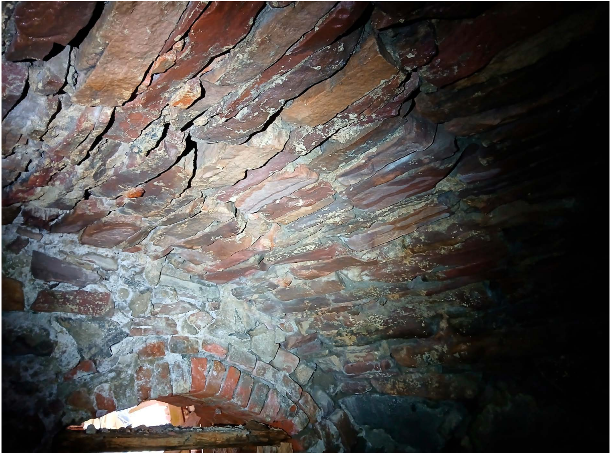
Lyttylän kellariholvien korjausneuvontaa. Kuva Anni Lehtimäki SatM
